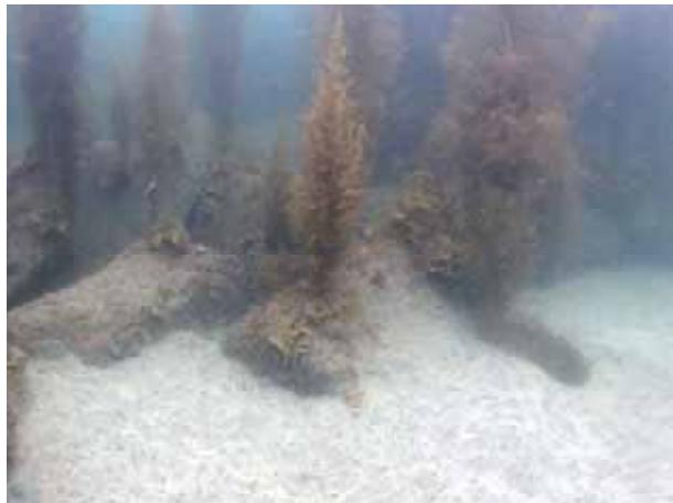
N-1\_03 東端 石材 埋没 30cm 程度
